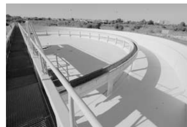
Epaisseur de station d'épuration
